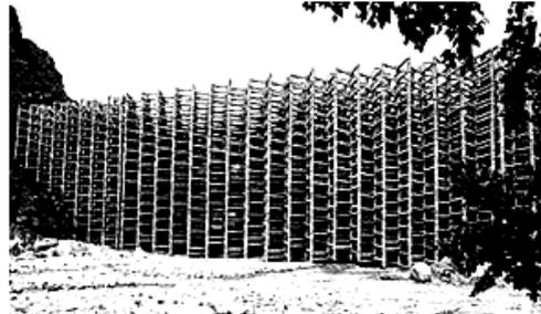
*Рис. 6. Сквозная противоселевая плотина из сборных ж/б элементов*
