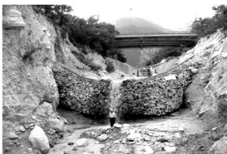
*Рис. 7. Защитная гибкая запруда типа "Illgraben" после заполнения*
