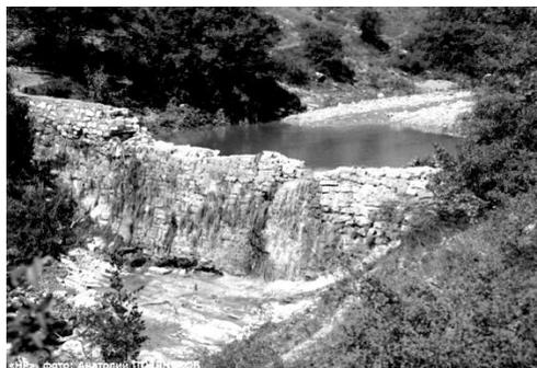
*Рис.4. Глухая противоселева плотина из каменной кладки*
