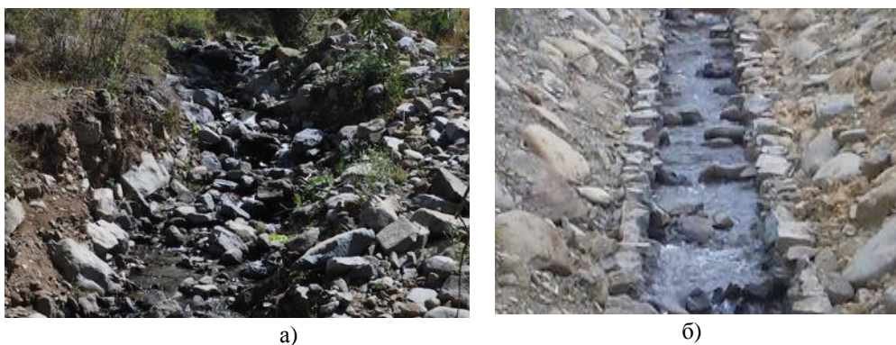
Рис. 2. Рыбоходы с увеличенным уклоном:
