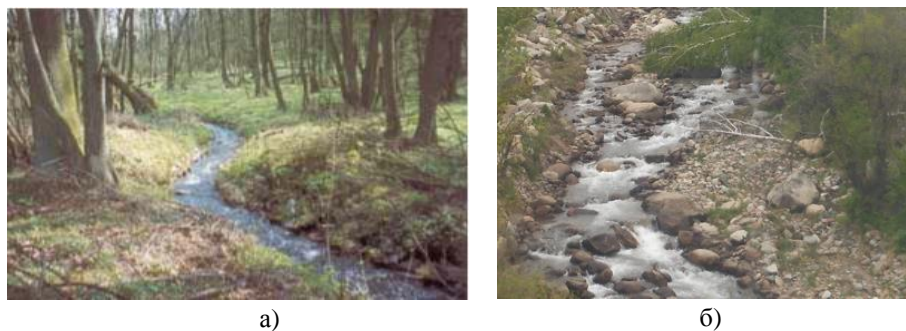
Рис. 1. Рыбоходы – байпасы: а - с меандрирующим руслом; б - со срезкой русла в пойменной части реки
