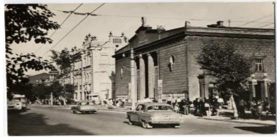
Рис. 10. Драматический театр им. Пушкина в г.Красноярске, реконструкция 1952-53гг. Г.Кочар (из фонда А.В.Слабухи)
