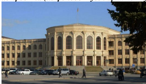
Рис. 8. Здание Горсовета в г.Ленинакане (ныне Гюмри). 1931-33гг. Г.Кочар (фото автора)
