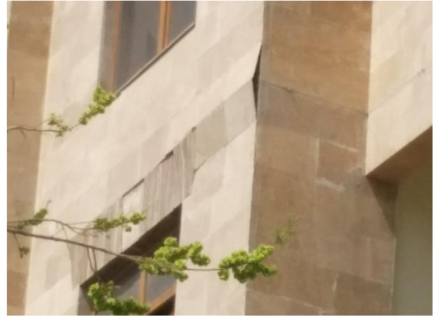
Նկ. 5. Քարե սալերի ջերմ. ընդարձակման հետևանքով երեսպատման բնորոշ քայքայում
