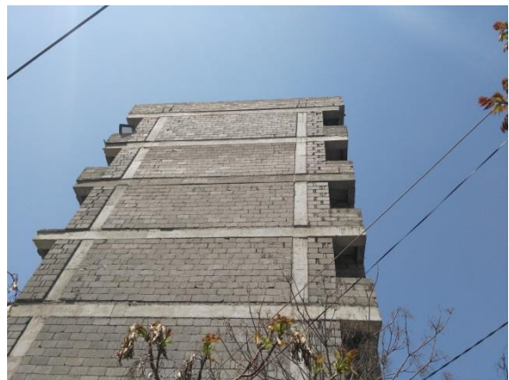
Նկ. 2. Կարկասային շենքի կողմնակառք երեսպատումից առաջ
