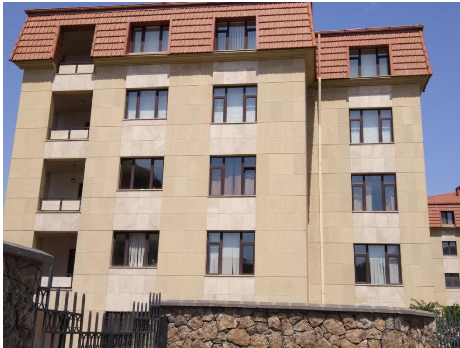
Նկ. 9. Դեֆորմացիոն կարաններով ջլատված շենքի ճակատի դրվագ
