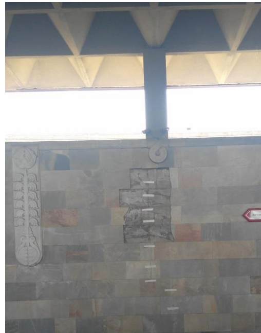
Նկ. 3. Մյան և պատի կցման տեղամասում երեսպատման քայքայման պատկերը
