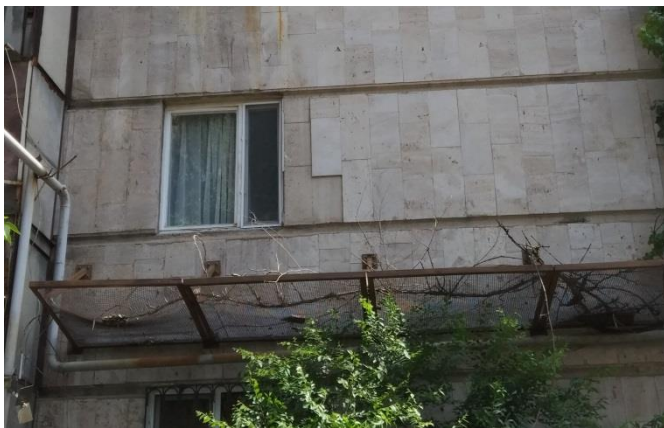
Նկ. 1. Պաշտպանիչ ճաղավանդակ սալաթափից պաշտպանվելու նպատակով
