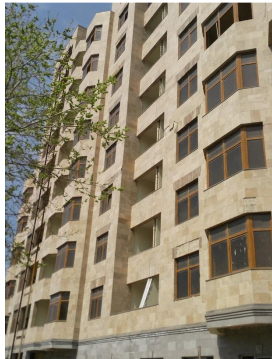
Նկ. 7. Երեսպատման քայքայման պատկերը շենքի ճակատում
