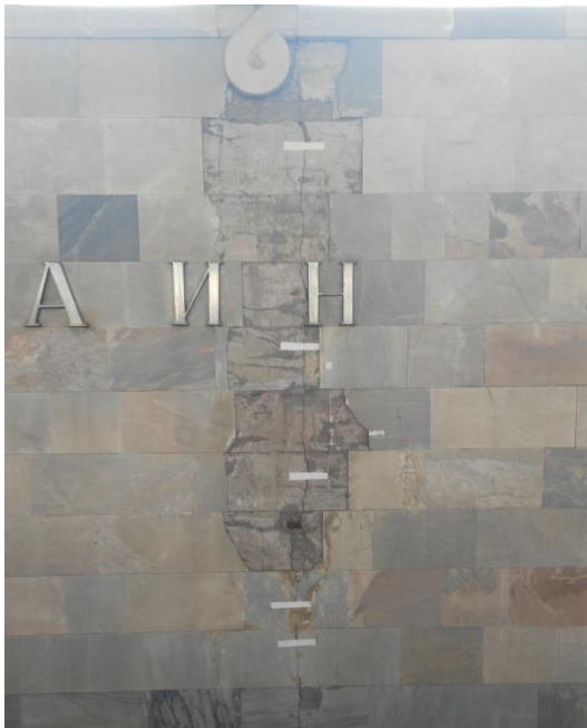
Նկ. 3. Մյան և պատի կցման տեղամասում երեսպատման քայքայման պատկերը
