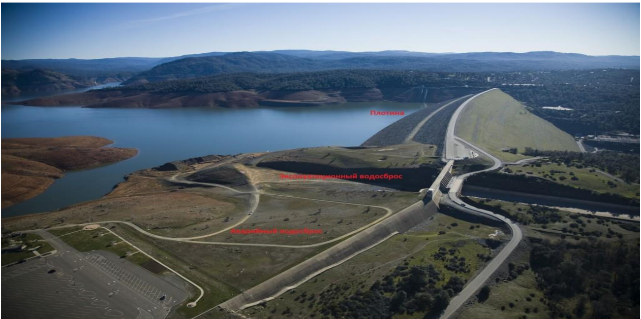
Նկ. 1. Օրովիլի հիդրոհանգույցի հատակագիծը և հիմնական կառուցվածքները
