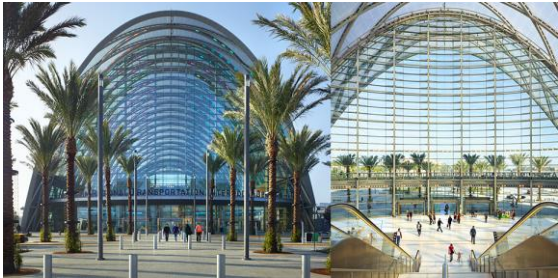
Նկ. 16. Կալիֆորնիայի առաջին արագընթաց երկաթուղային կայարանի վերականգնումը ETFE պոլիմերային ծածկի կիսումամբ, ԱՄՆ
