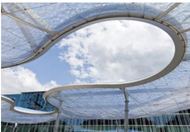
Նկ. 8. Աարաուի ավտոկայանի ծածկ, իրականացված ETFE պոլիմերով, Շվեյցարիա (2013 թ.)
