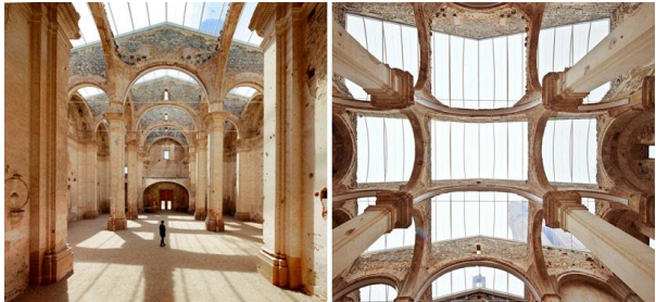
Նկ. 15. Տարագոտտայի կիսավեր եկեղեցու կոնսերվացում ETFE պոլիմերային նյութի օգտագործմամբ, Բսպանիա
