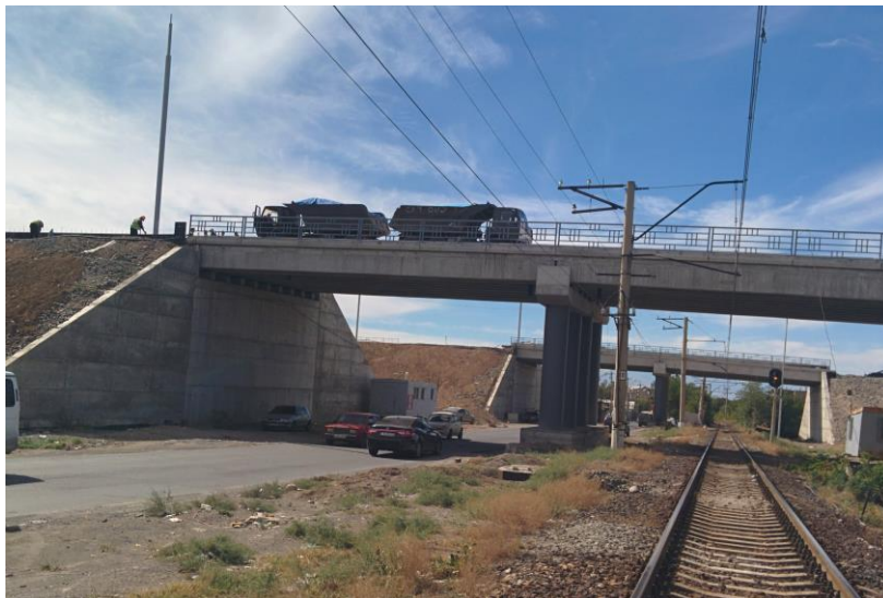
Նկ. 2. Ուղեկամրջի վրա փորձարկվող բեռնվածքի տեղադրման պահը և ընդհանուր տեսքը
