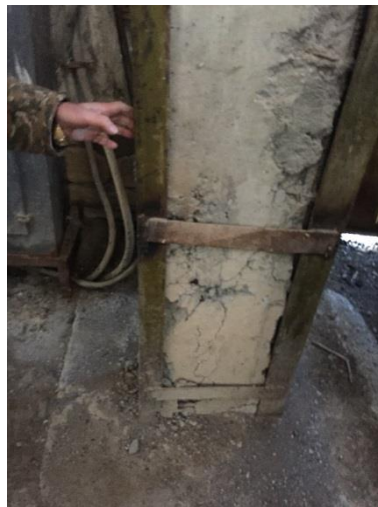
Նկ. 3. Տեխնիկայի կայանակետի կրող սյան քայքայվածության ընդհանուր տեսքը
