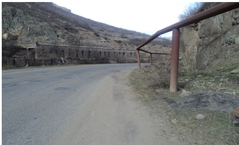
Նկ.4. 37,2 կմ, Ճանապարհի երթևեկելի մասի վրա գազի խողովակի տեղադրում
