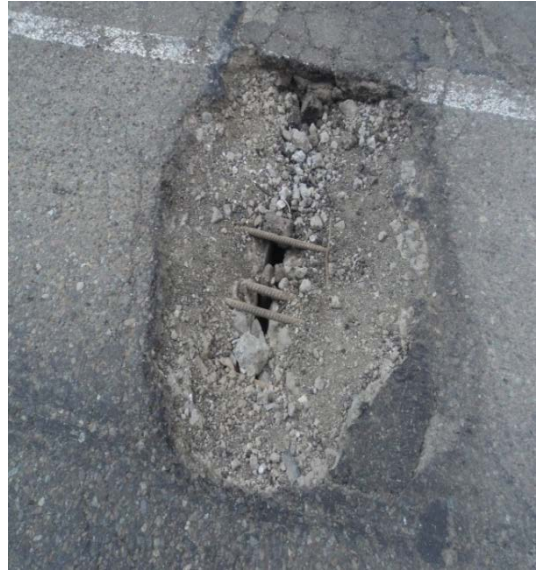
բ) գ) Նկ. 3. 30,7 կմ, Ձորագետ, քայքայված կամուրջ. ա-կամրջի ընդհանուր տեսքը, բ, գ-կամրջի վրա քայքայված երթևեկելի մաս
