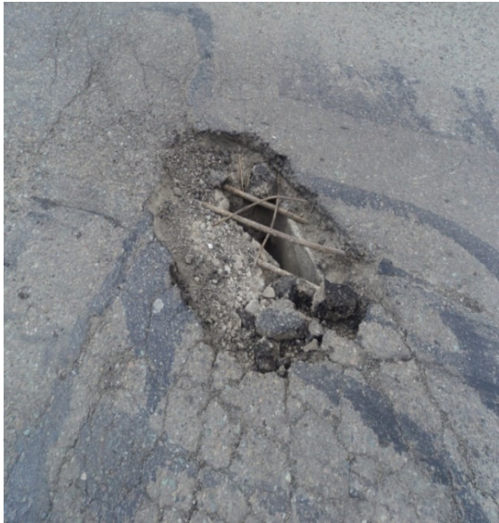
բ) գ) Նկ. 3. 30,7 կմ, Ձորագետ, քայքայված կամուրջ. ա-կամրջի ընդհանուր տեսքը, բ, գ-կամրջի վրա քայքայված երթևեկելի մաս
