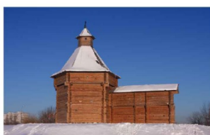
Башня Сумского острога
